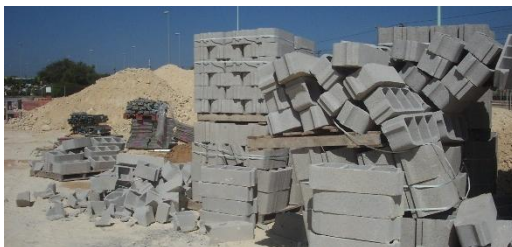
Rotura de material por acopio indebido
